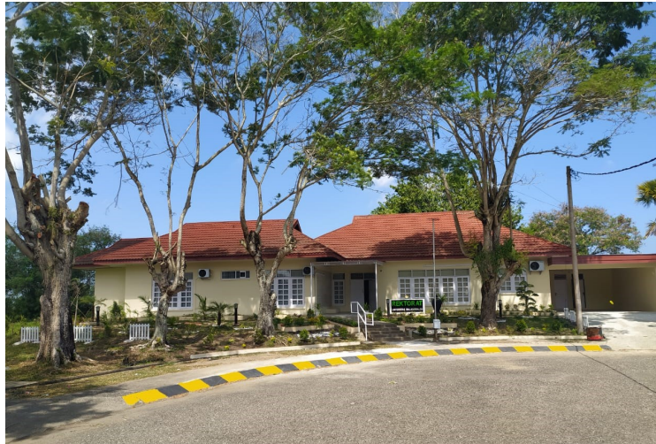
Gedung Rektorat Universitas Malikussaleh di Kampus Bukit Indah, Lhokseumawe
