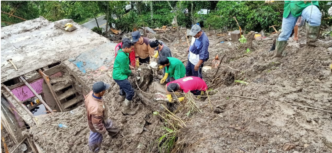
Mahasiswa Unimal membantu proses pembersihan material sisa banjir di lokasi bencana, Aceh Tengah, Minggu (17/5/2020). Foto; Ahmad Al Bastin
