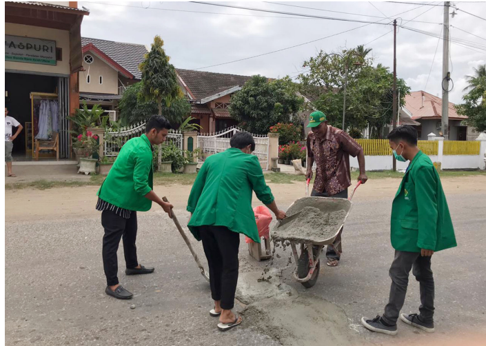
Mahasiswa KKN dari Kelompok 193 bersama Keuchik Paya Dua Kecamatan Banda Baro, Aceh Utara, Tarmizi Ar, menambal jalan yang rusak akibat hujan, belum lama ini. Foto: Ist.
