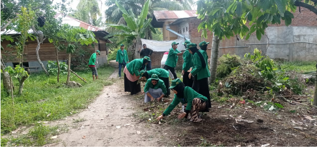
Mahasiswa KKN-PPM 143 sedang ikut dalam pembangunan jalan lorong di Gampong Blang Panjo, Bireuen. Foto : Ist
