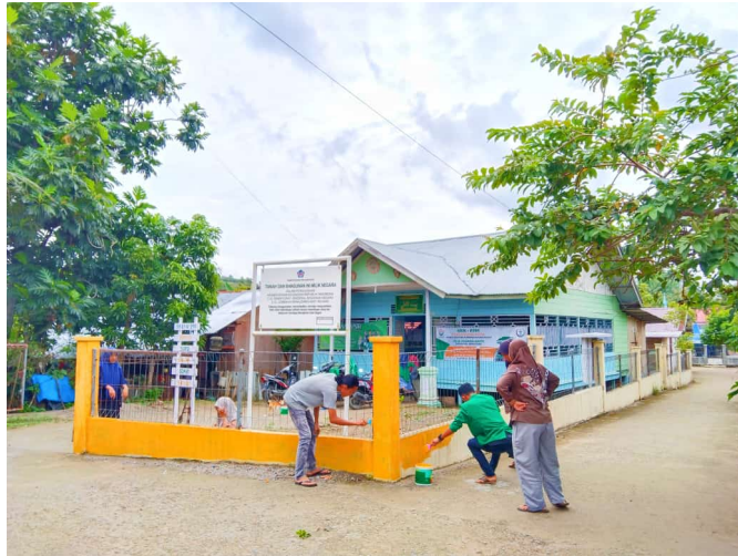
Kelompok 148 KKN Unimal melaksanakan pengecatan pagar balai pengajian yang ada di Dusun Tgk Dipanyang, Gampong Padang Sakti, Kecamatan Muara Satu Lhokseumawe, Kamis (18/11/2021).Foto: Ist.
