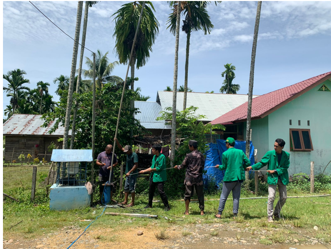
Mahasiswa KKN Kelompok 16 Perbaiki Pipa Sumur Bor yang Rusak Akibat Banjir. Foto: Ist
