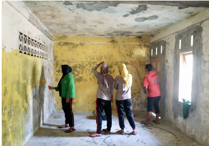
Mahasiswa KKN di Desa Krueng Seupeng Kecamatan Kuta Makmur, Aceh Utara, merenovasi gedung TK Al Kahfi di desa tersebut, Sabtu (31/8/2019). Foto: IST.
