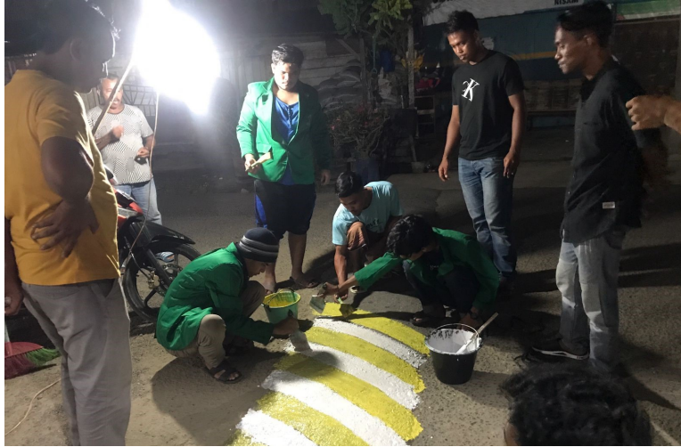
Mahasiswa KKN-PPM 06 Unimal lakukan pengecatan polisi tidur (Speed Bump) di Gampong Tingkeum, Kecamatan Nisam, Kabupaten Aceh Utara, Selasa (13/6/2023).
