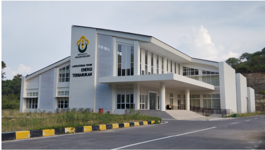
Gedung Laboratorium Teknik Energi Terbarukan, Fakultas Teknik, Universitas Malikussaleh di Kampus Bukit Indah. Foto: Ist
